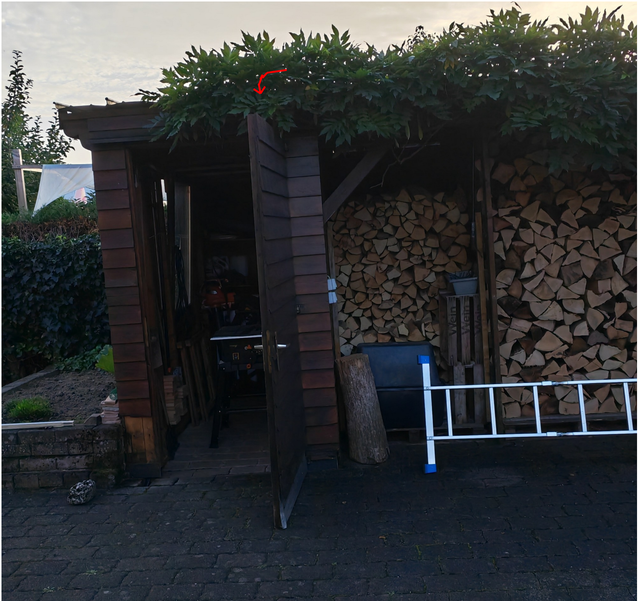
Stringkabel und Erdung mit Schutzrohr in Spalt zwischen Holzkonstruktion und Dach einführen. Wechselrichter Standort direkt hinter der Tür auf der Rechten Seite
